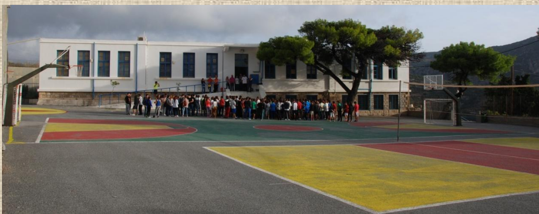
Το κτίριο του Γενικού Λυκείου Κυθήρων σήμερα (2014)
